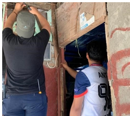
Gambar 5. Perbaikan Instalasi Listrik
